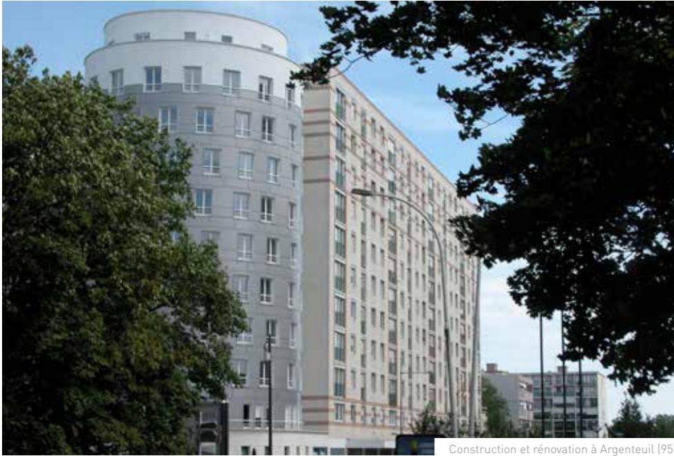
Construction et rénovation à Argenteuil (95)
